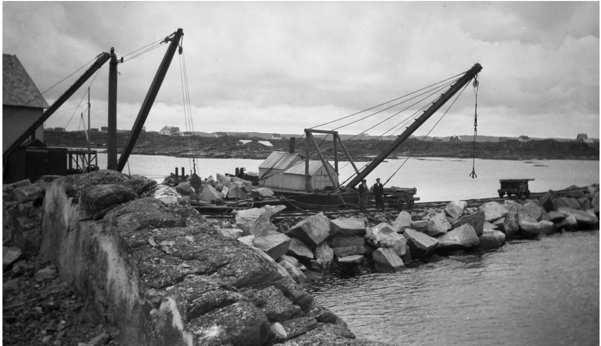
Bygging av moloen sør-aust for Mortholmen. Foto: Kristian Berge
