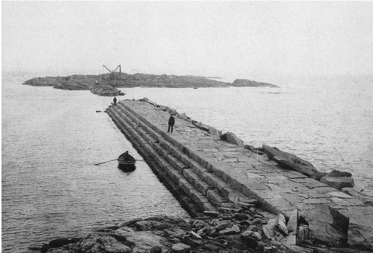
Bygging av moloen mellom Søre Varholmen og Mortholmen
